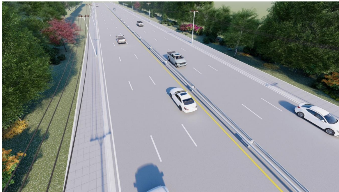
รูปที่ 5.2-8 (ต่อ) เกาะกลางแบบราวกันอันตราย สำหรับทางหลวงหมายเลข 12 ช่วงเขตทางกว้าง 30 เมตร
