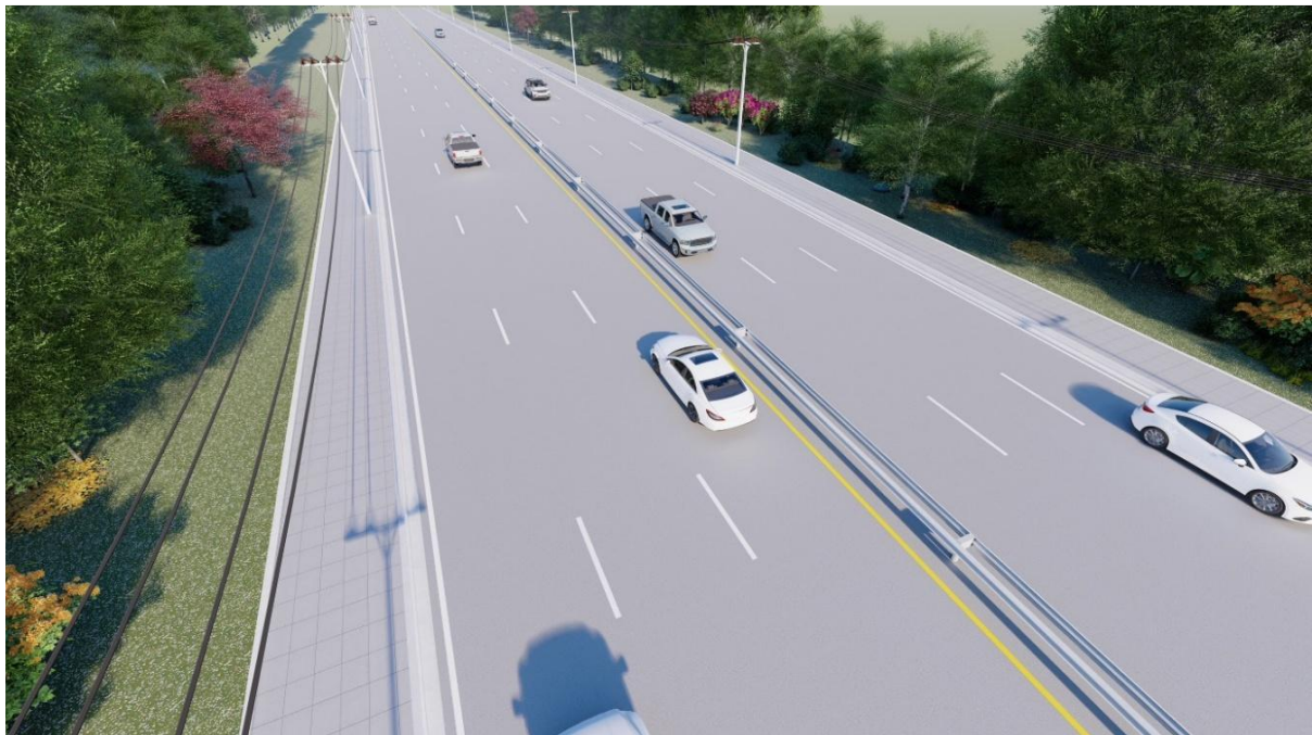
รูปที่ 5.2-1 เกาะกลางแบบราวกันอันตราย สำหรับทางหลวงหมายเลข 12 ช่วงเขตทางกว้าง 30 เมตร
