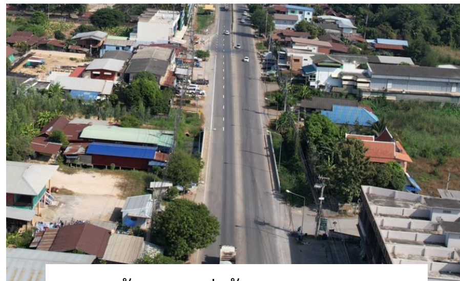
สะพานข้ามคลองท่าช้าง กม. 169+192
