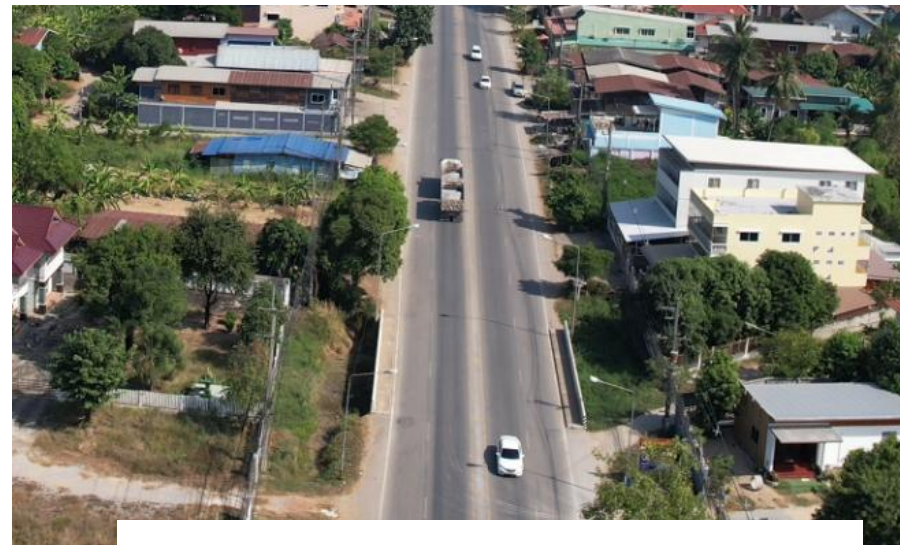
สะพานข้ามคลองขุด กม. 168+905
