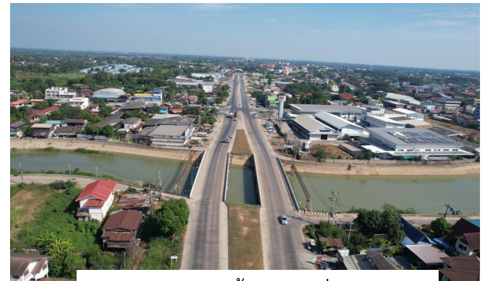
สะพานข้ามแม่น้ำยม กม.ที่ 82+277
